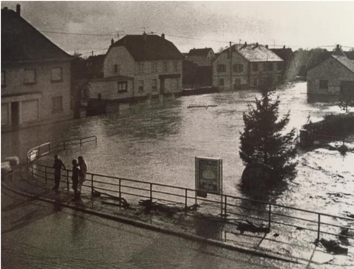
Crue de 1990, pont du Schecklenbach
